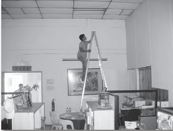
◀ 汰换行政楼各楼层办公室灯管座工程。
